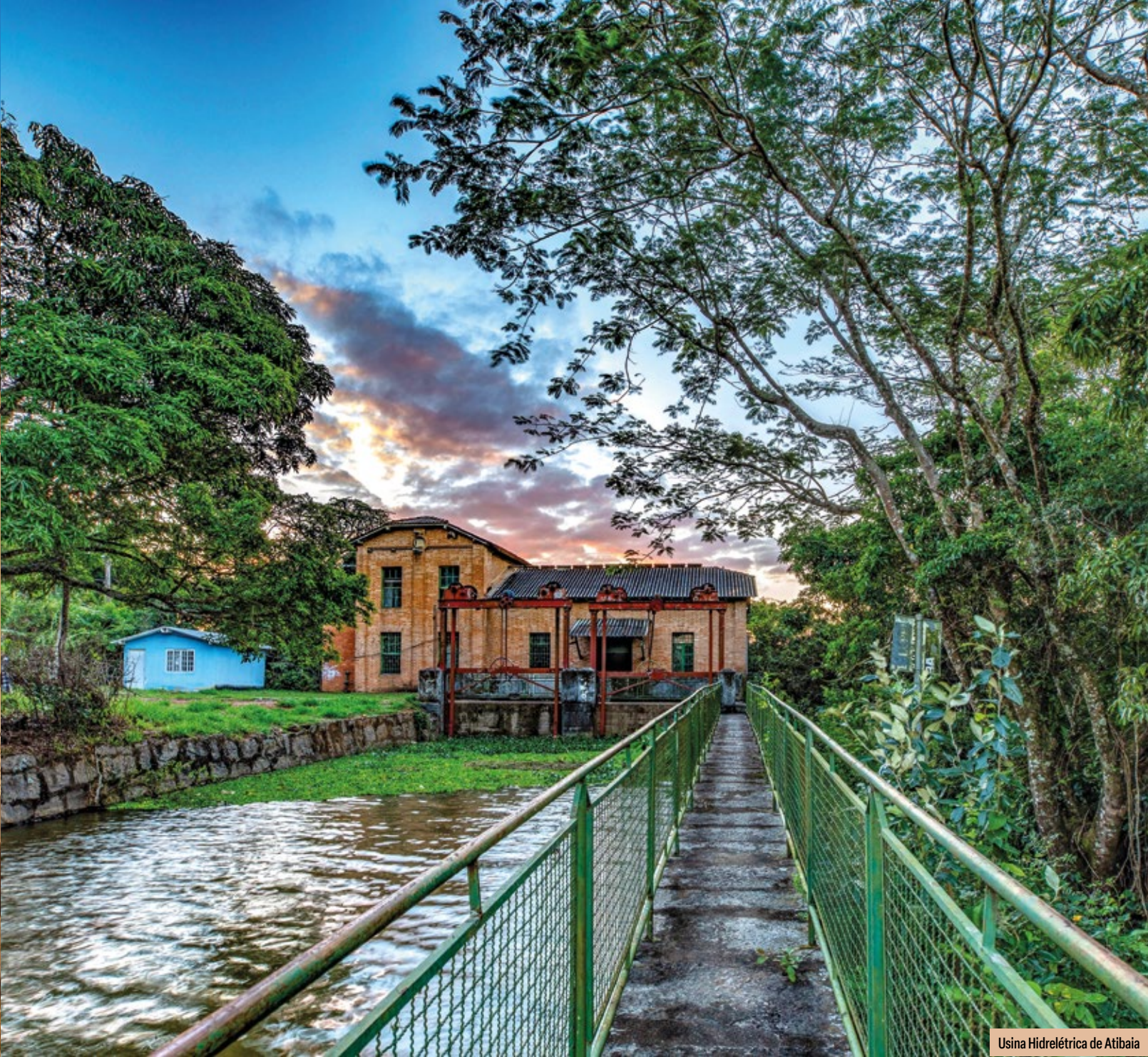
Usina Hidrelétrica de Atibaia
